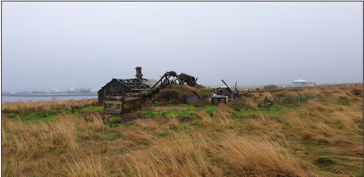
Vegamót 065_1 og 2, horft til NNV
